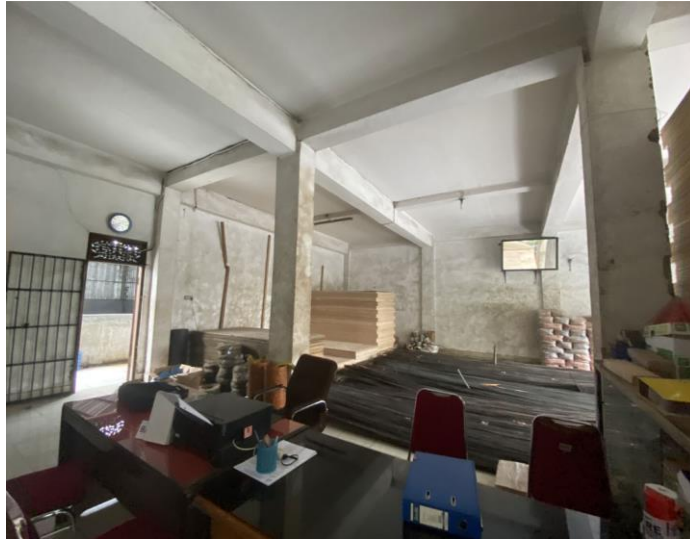
Gambar 7. Kondisi Lantai Satu [Sumber: Data Pribadi 2022]
