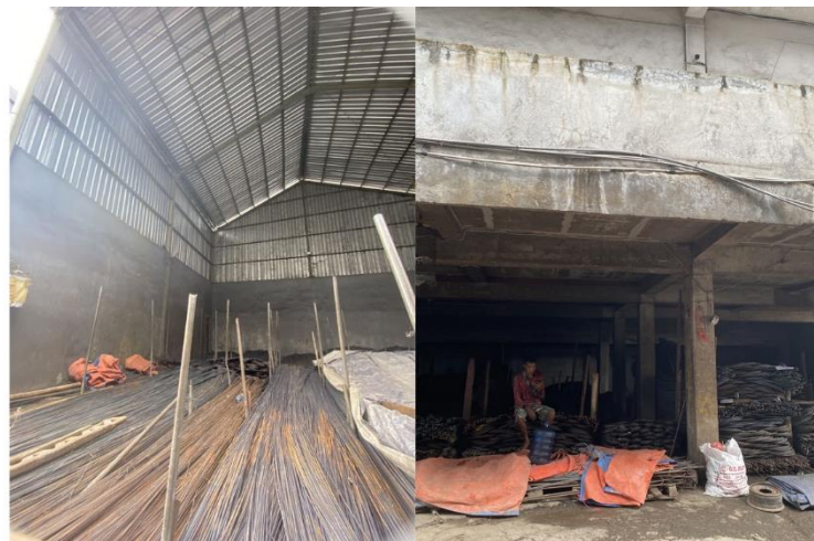
Gambar 8. Kondisi Basement [Sumber: Data Pribadi, 2022]
