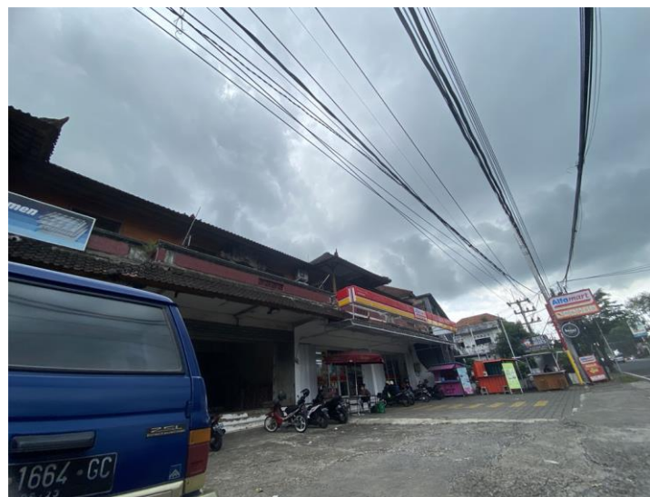
Gambar 6. Kondisi Bangunan [Sumber: Data Pribadi 2022]
