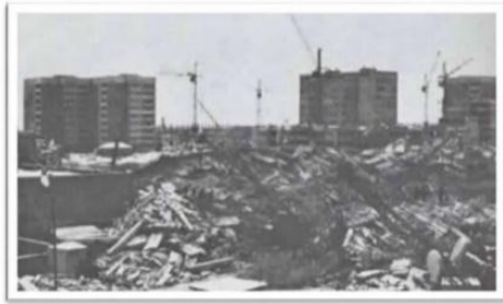
Gambar 2. Bangunan prefabrikasi terlihat utuh 1988, Armenia
