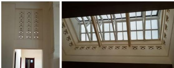
Gambar 7. Laggam Art Deco dengan material roster pada pembatas dinding dan *void*. (sumber: Sahira, 2022)
