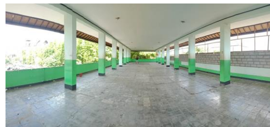
Gambar 8. Kondisi Bangunan Utama Sumber: Dokumentasi pribadi, 2019
