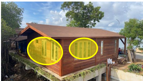
Gambar 04. Ventilasi dan bukaan bagian belakang dan samping bangunan Sumber: Utami, 2023
