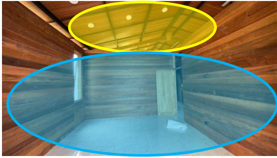
Gambar 07. Ruang terbuka pada plafond (kuning), pembatas dinding interior bangunan Sumber: Utami, 2023
