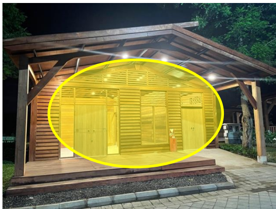
Gambar 03. Ventilasi dan bukaan bagian depan bangunan Sumber: Utami, 2023
