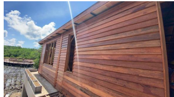
Gambar 14. Pemasangan Kayu Merbau pada dinding Bangunan Sumber: Utami, 2023
